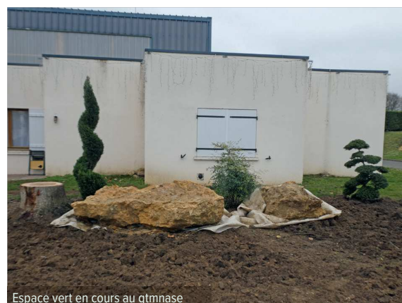
Espace vert en cours au gymnase
