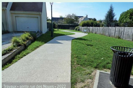
Travaux - sente rue des Noues - 2022
