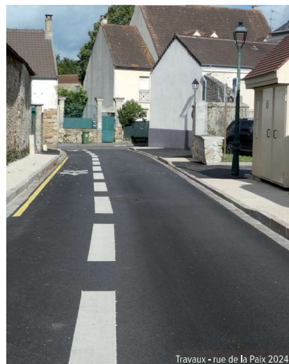
Travaux - rue de la Paix 2024
