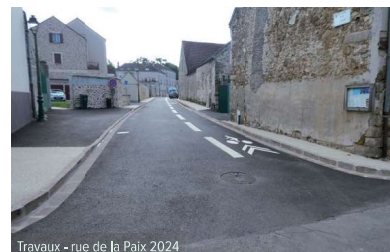
Travaux - rue de la Paix 2024
