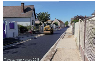
Travaux - rue Herses 2018
